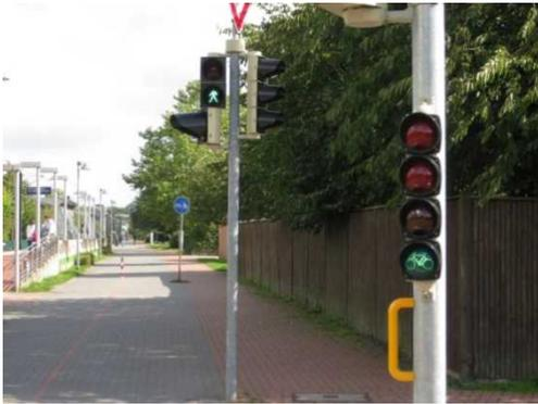
Getrennte Signalisierung des Radverkehrs und des Fußgängerverkehrs /Haltegriff für Radfahrer (H)
