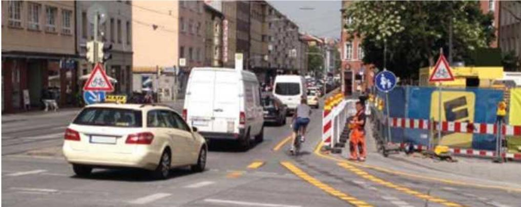
Abb. 91 Radverkehrsführung in Baustellenbereichen (AGFK)
