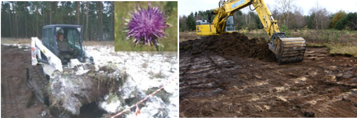
Abb. 62 + 63: Abplaggen mit Raupe bzw. Bagger
