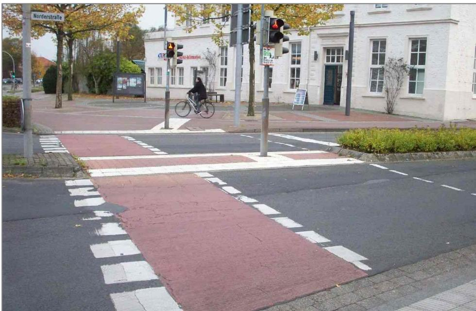
Abb. 10: *barrierefreie Querung an einer LSA in Aurich*
