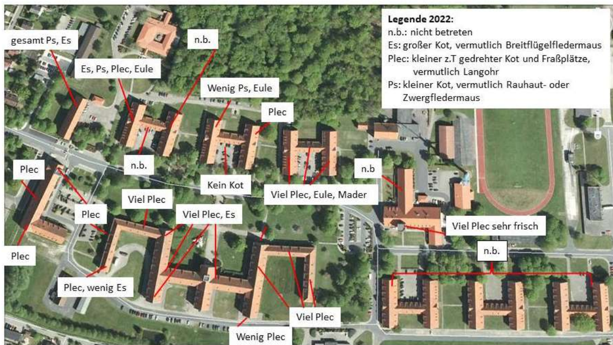
Abb. 1b: Ergebnisse der Gebäudekontrolle – 2022
