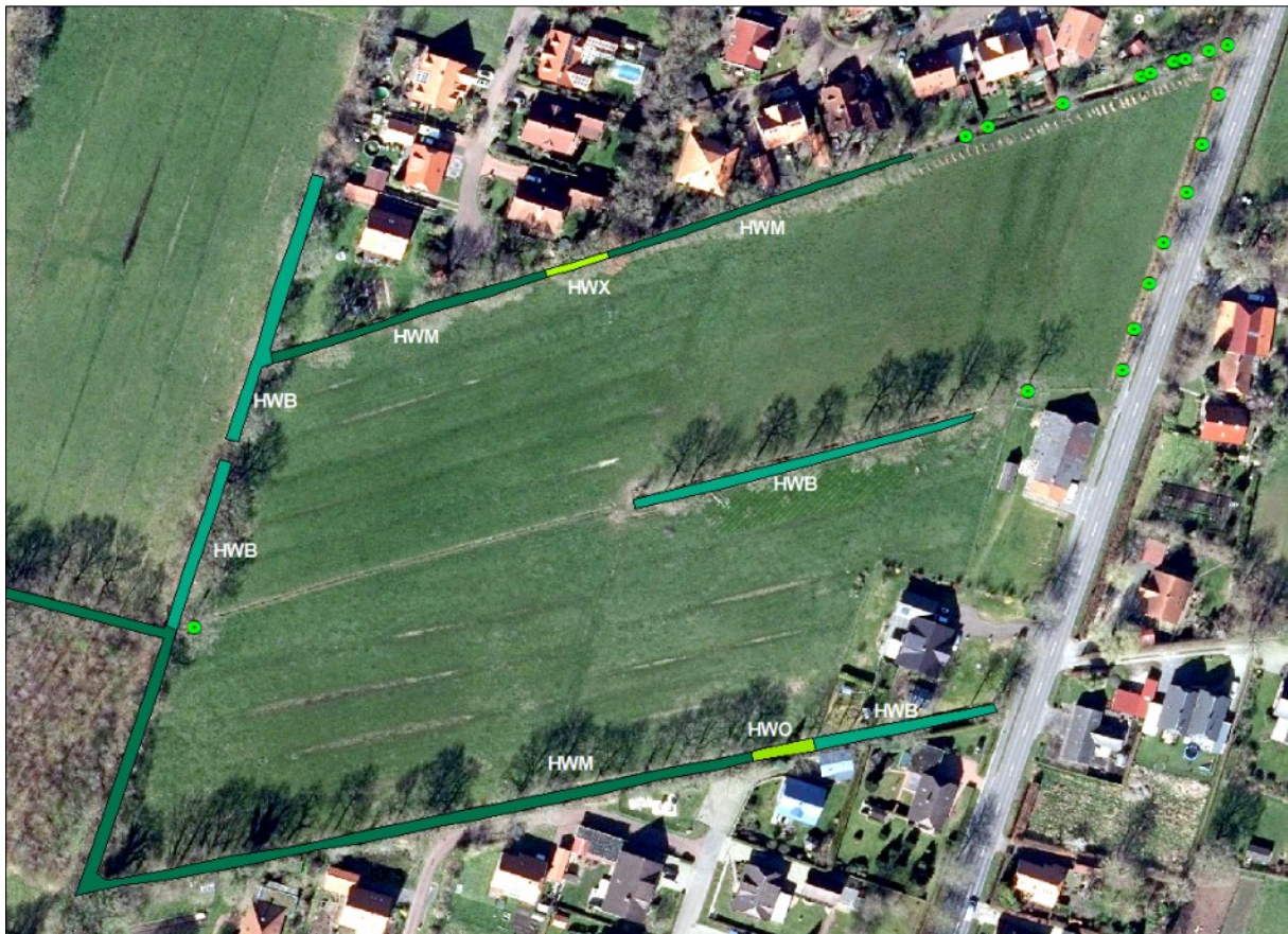
Abbildung 7: Wallhecken im Untersuchungsgebiet, Grundlage Luftbild 2020 (Luftbild: https://www.opengeodata.lgln.niedersachsen.de/#dop ).
