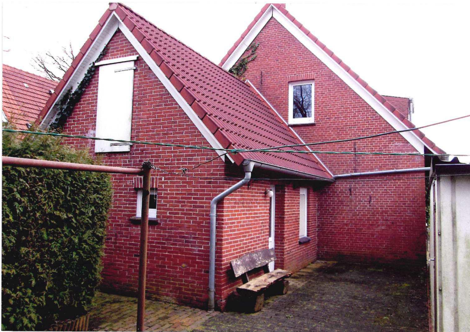
Hintere Ansicht mit Wohnhausanbau und Garage
