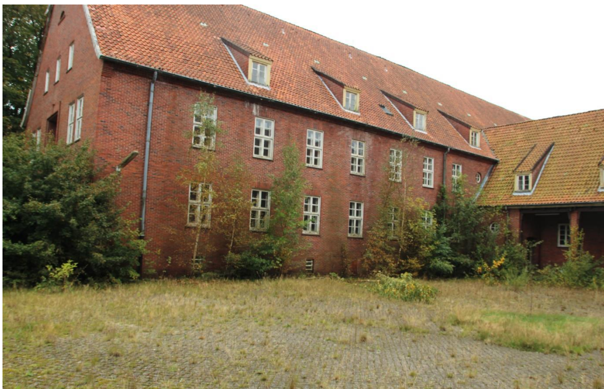
Abb. 17: Gehölzentwicklung in einem gepflasterten Innenhof
