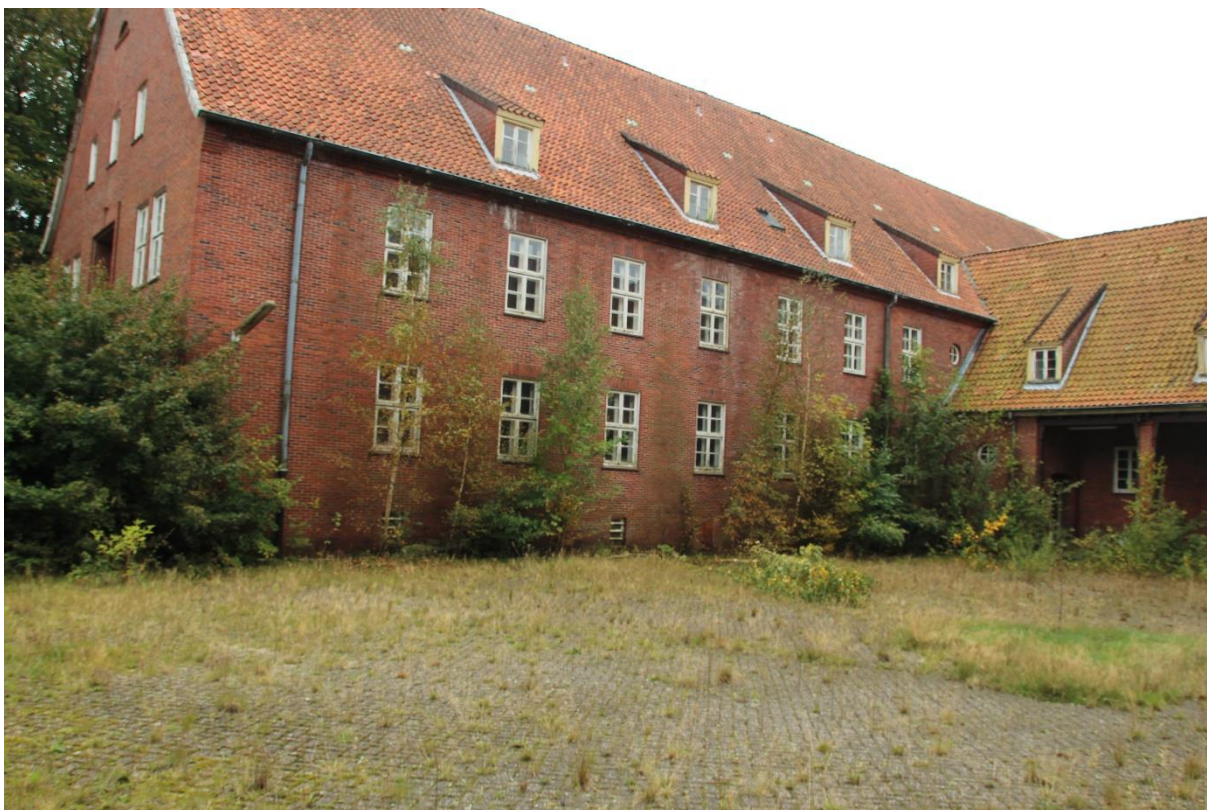
Abb. 4: Blick auf die verlassenene Gebäude mit Spontanvegetation
