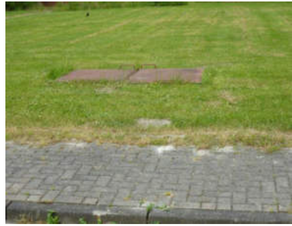
Abdeckung der Zisterne
