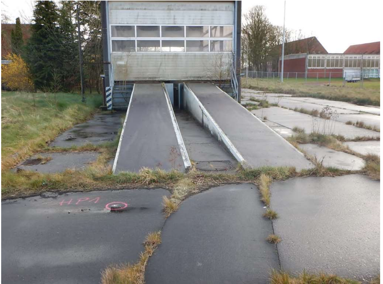
Höhenbezugspunkt Schachtdeckel und Hilfpunkt HP1
