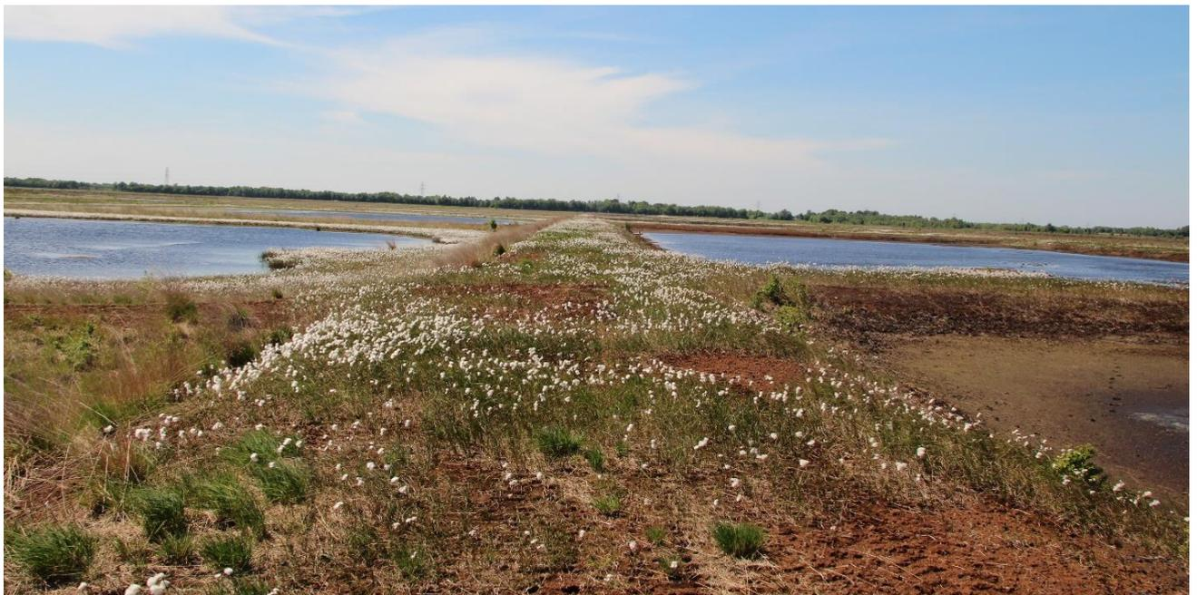
**Abb. 11:** Beispiel für eine gelungene Hochmoorrenaturierung im Stapeler Moor mit Dammsystem
