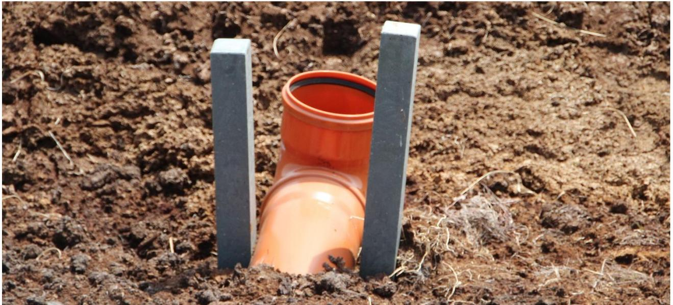
**Abb. 13:** Beispiel für eine einfache Überlaufvorrichtung
