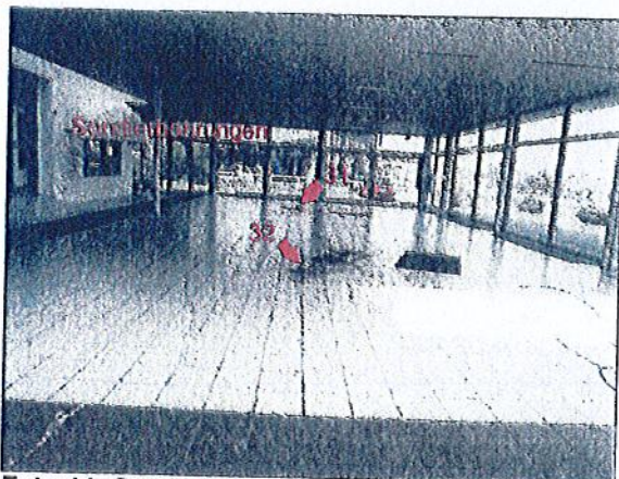
Foto 11: Sondierbohrungen in der Ausstellungshalle
