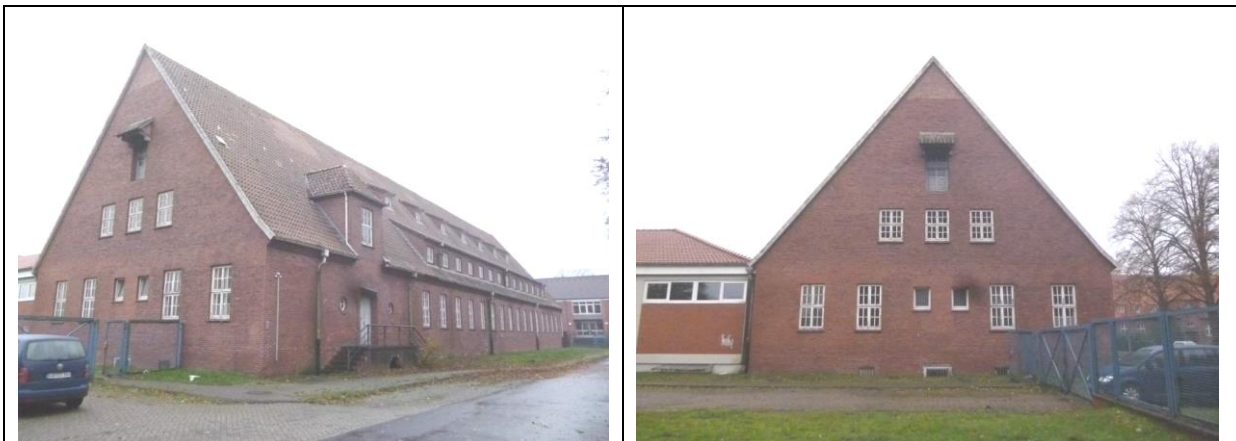
Gebäude Nr. 17 Baudenkmal südlich Quartiersplatz
