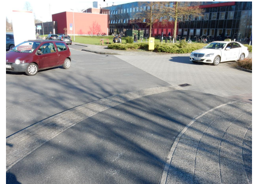
Radweg endet ohne Hinweisschild (Wallinghausener Str.)
