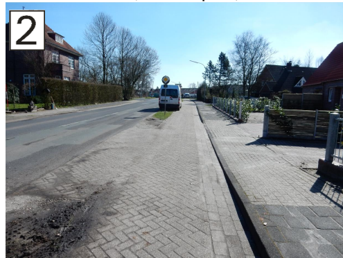
2 Schmaler Getr. Geh- und Radweg im Zweirichtungsbetrieb (Wallster Weg)
