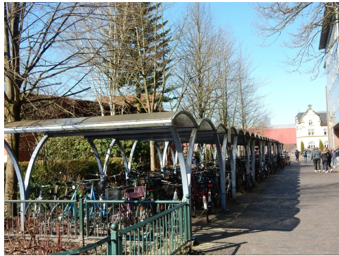
Überdachte Abstellanlagen am Gymnasium Ulricianum
