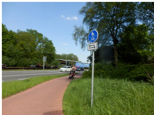
Abb. 9 Zweirichtungsradweg (Emder Straße, Aurich)
