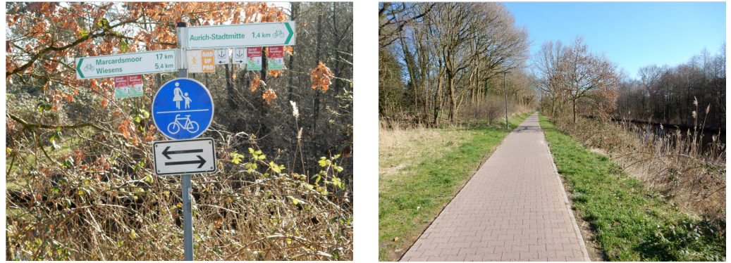
Abb. 40 Radweg am Ems-Jade-Kanal
