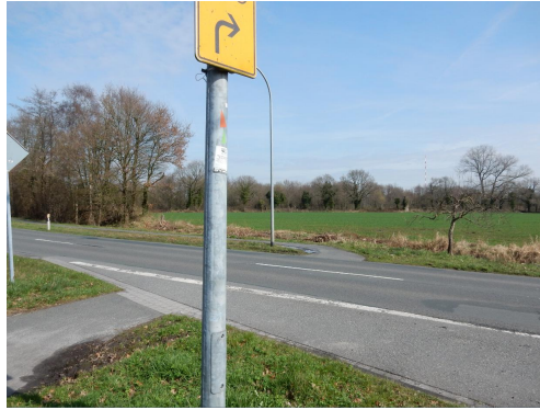
Fehlende Querungshilfe (Kirchdorfer Straße)
