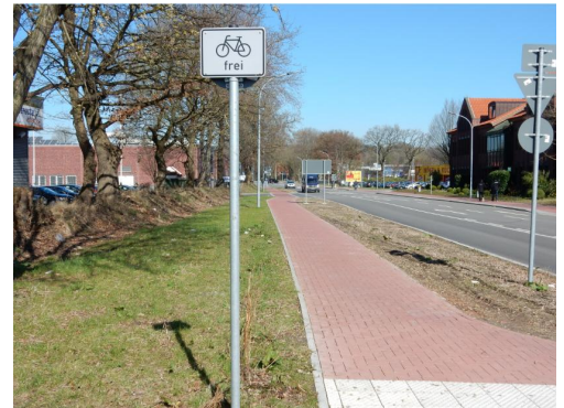
Gehweg Radfahrer frei (Westseite Dreekamp, Aurich)
