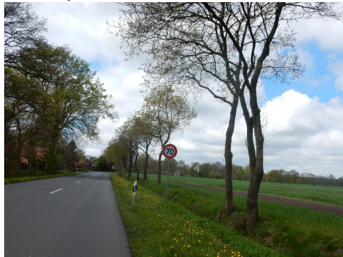
Fehlende Radverkehrsanlage außerorts (Spekendorfer Str.)
