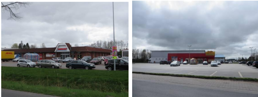
Abb. 17: Markant, NVZ Emders Straße Riepe, Netto, Riepe - EG Ihlow
