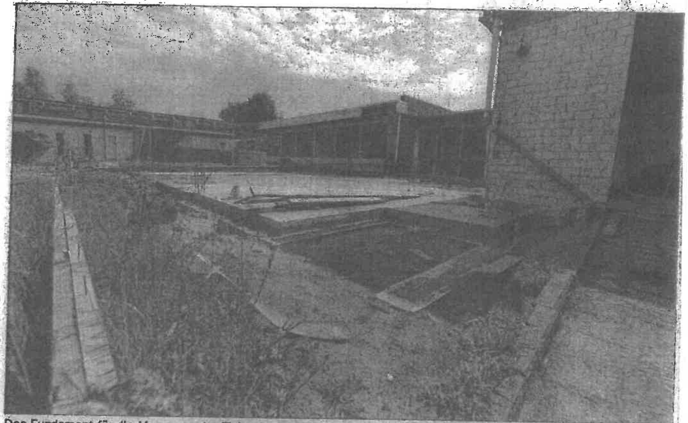
Das Fundament für die Mensa an der Finkenburgschule in Aurich wurde bereits gegossen.
