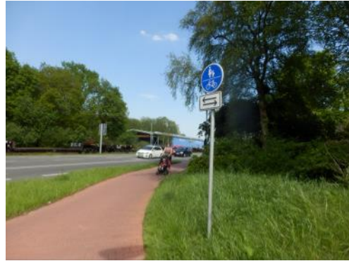
Zweirichtungsradweg innerorts (Emder Straße)
