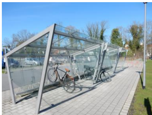
Überdachte Abstellanlagen am Frei- bad
