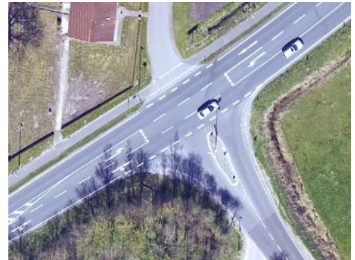
Fehlende Querungshilfe ( Abzweig Esenser Str./Spekendorfer Str.)
