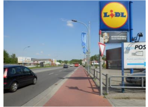
Zweirichtungsradweg innerorts an Einmündung (Emder Straße)
