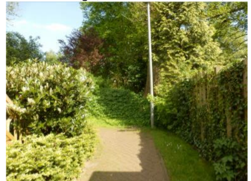
Selbstständig geführter Radweg – schlechte Sichtbeziehung
