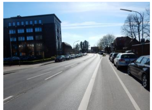
Radfahrstreifen (1,40 m) – fehl. Trennstreifen (Jul.-burger Str.)
