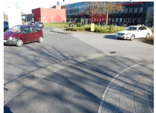
Radweg endet ohne Hinweisschild (Wallinghausener Str.)
