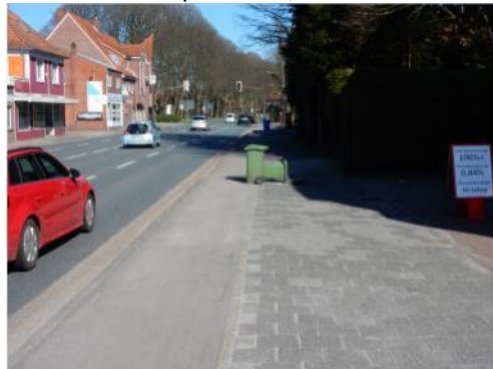
Eingeschränkte nutzbare Breite des Radweges (Esenser Straße)
