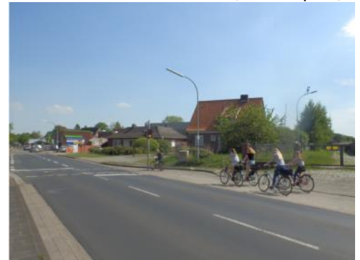
Ende Radweg an LSA – fehlendes Hinweisschild (Wallster Weg)
