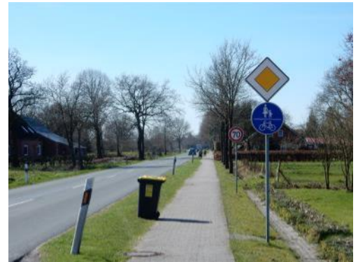
Unbeleuchteter schmaler gem. Geh- und Radweg (Moordorfer Straße)
