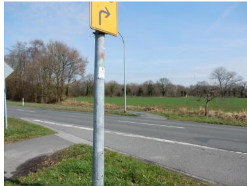
Fehlende Querungshilfe (Kirchdorfer Straße)
