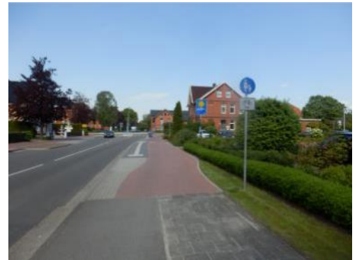
Gehweg Radfahrer frei – Im Bereich vom Kreisverkehr (Oldersumer Str.)
