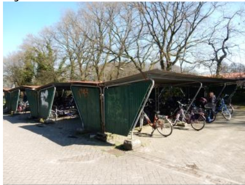
Überdachte Abstellanlagen an der IGS Aurich-West
