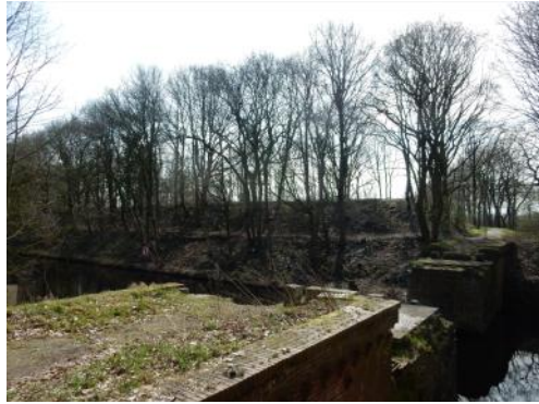
Abb. 50 Fehlende Radverkehrsbrücke über den Ems-Jade-Kanal
