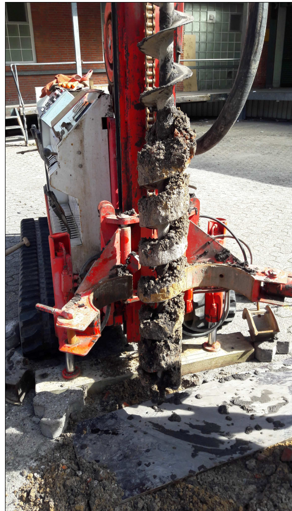
Foto 2: Schneckenbohrung 3
