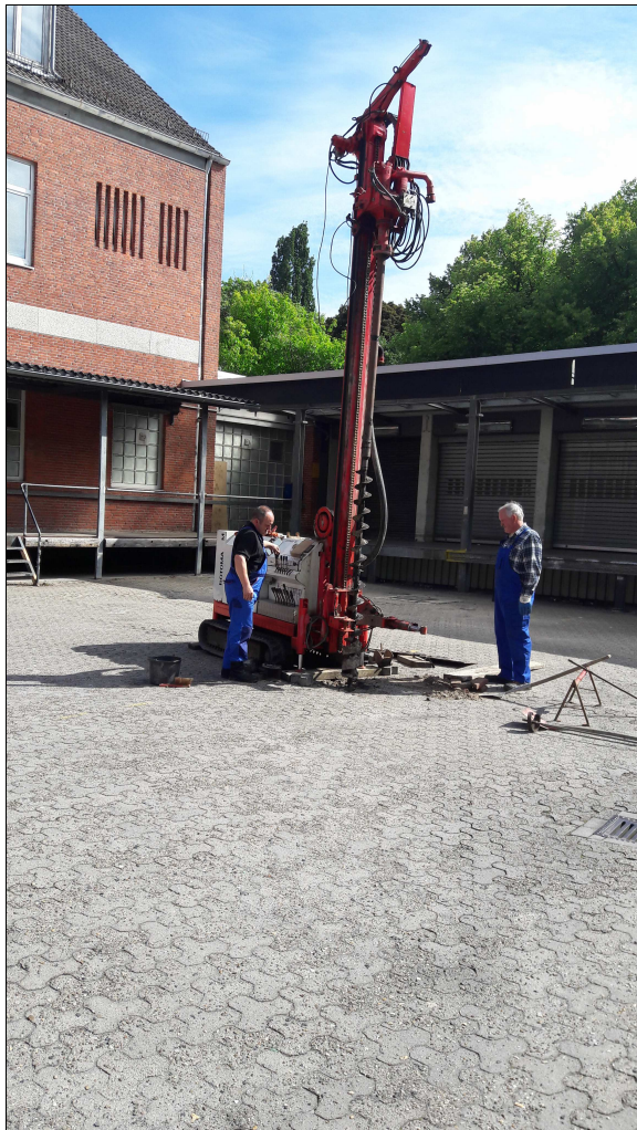
Foto 1: Niederbringung Schneckenbohrung
