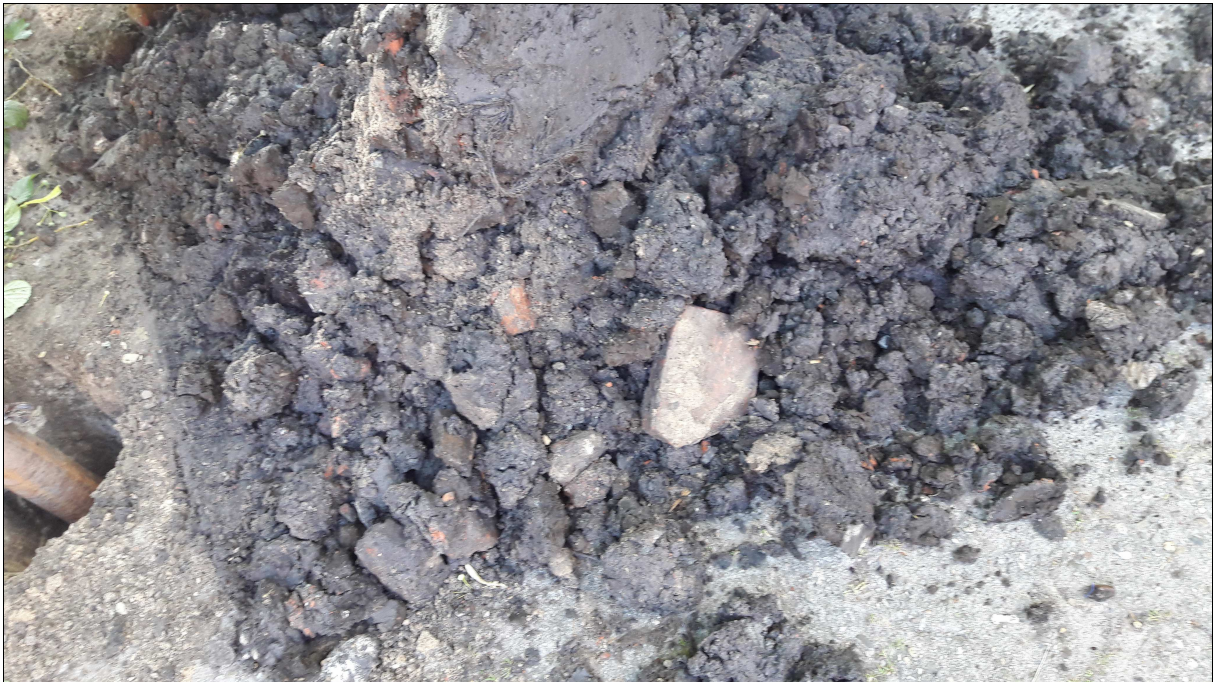
Foto 3: Bohrgut: Boden mit Bauschuttresten
