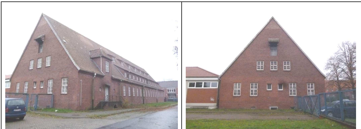
Gebäude Nr. 17 Baudenkmal südlich Quartiersplatz
