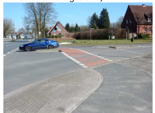
Abgesetzte Radverkehrsfurt (Esenner Straße/Skagerrakstraße)
