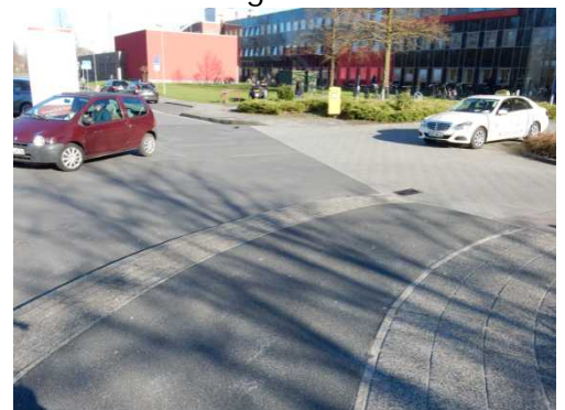
Radweg endet ohne Hinweisschild (Wallinghausener Str.)
