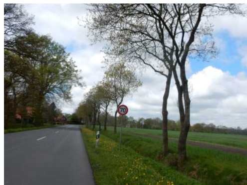
Fehlende Radverkehrsanlage außerorts (Spekdorfer Str.)
