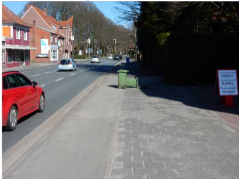
Eingeschränkte nutzbare Breite des Radweges (Esenser Straße)
