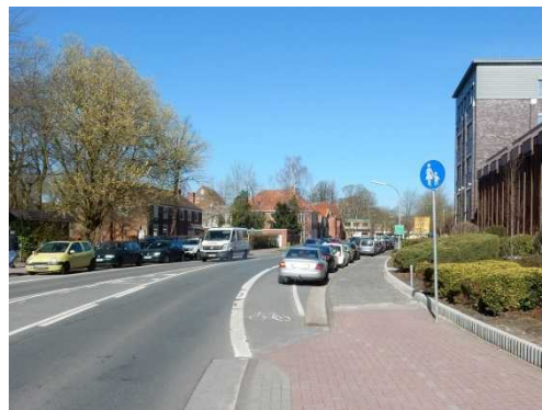
Radfahrstreifen (1,40 m) – fehl. Trennstreifen (Jul.-burger Str.)
