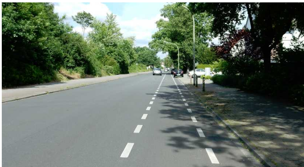
Abb. 50 Einseitige Markierung von Schutzstreifen
