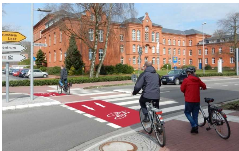
Abb. 70 Regelkonforme Markierung an Kreisverkehren
