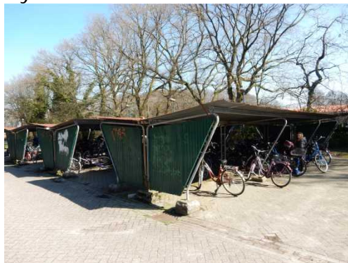
Überdachte Abstellanlagen an der IGS Aurich-West
