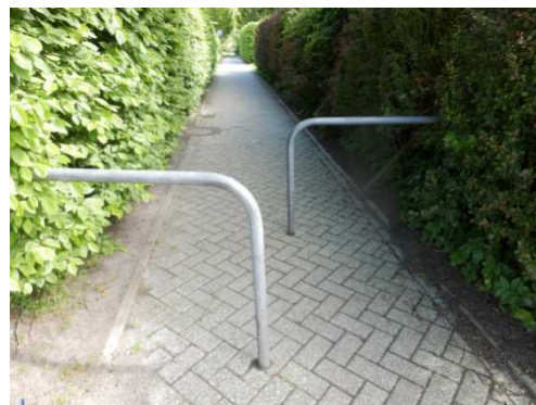
Enge Umlaufsperrn (Rhododendronstraße)
