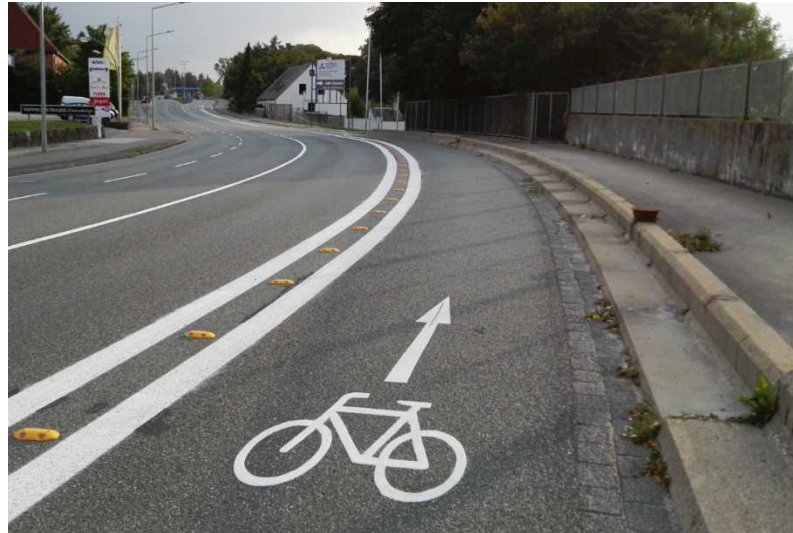
Abb. 63 Beispiel einer Protected Bike Lane in Flensburg
